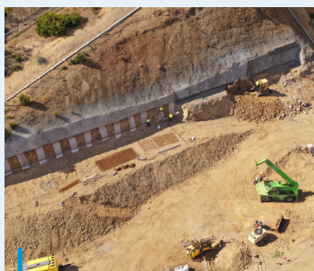
Réalisation du « rognage » du talus pour terrasser la zone qui accueillera le futur poste de raccordement au réseau haute-tension de la Corse.
