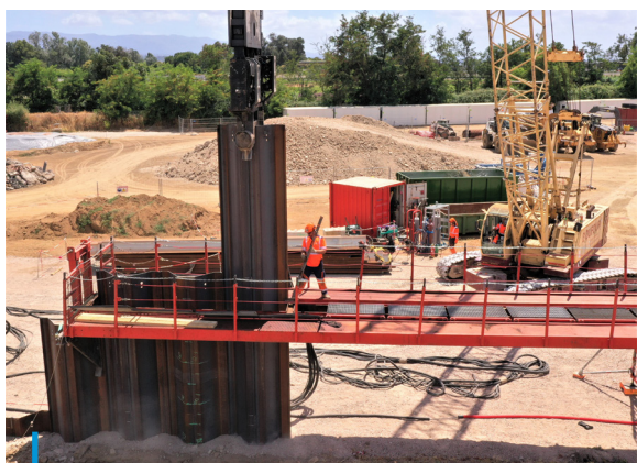
Installation des palplanches
