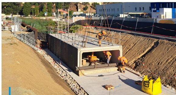
Installation d'un large dalot permettant un meilleur écoulement des eaux
