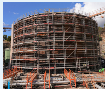
Rénovation du premier des 3 réservoirs qui accueillera la biomasse liquide, combustible de la future centrale
