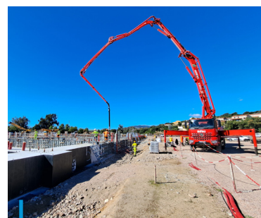
Coulage du béton
